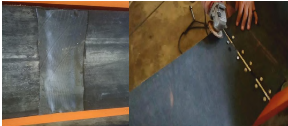
Gambar 4. 6 Penyambungan belt
