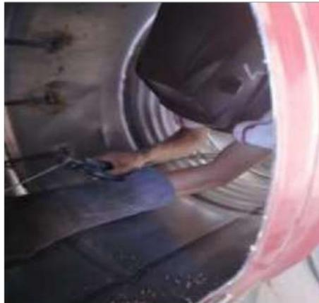
Gambar 4. 9 proses pengelasan besi angker untuk sirip-sirip
