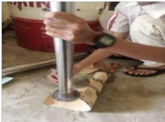
Gambar 4. 30 proses pembuatan paking antara penyambungan pipa besi
