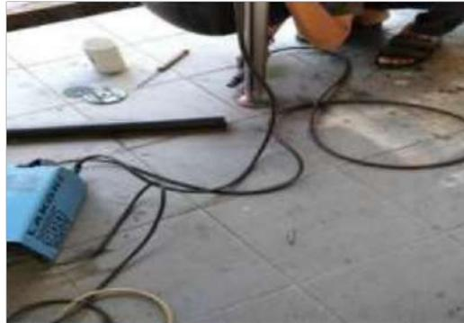
Gambar 4. 29 Proses pengelasan plat dan pipa besi untuk penyambungan
