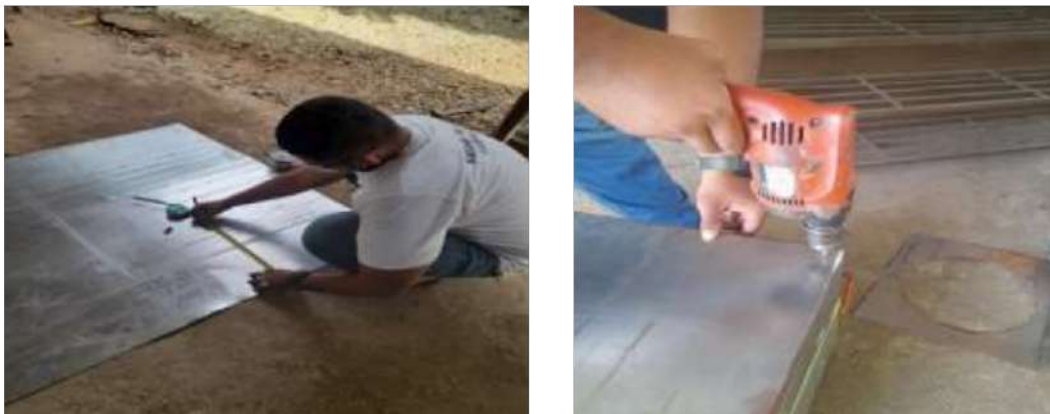
Gambar 4.7 Pelubangan Tabung Bagian Dalam dan Pelubangan Dinding Rangka Dengan Mesin Bor
