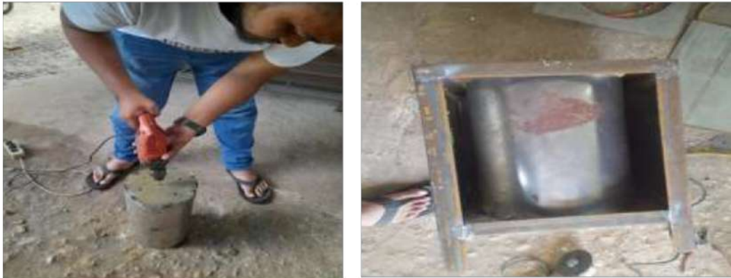
Gambar 4.6 Pelubangan Tabung Bagian Dalam dan Pemasangan Tabung ke dalam Rangka
