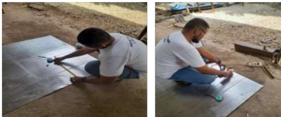
Gambar 4.5 Proses Pengukuran Besi Plat dan Pemotongan Besi Plat
