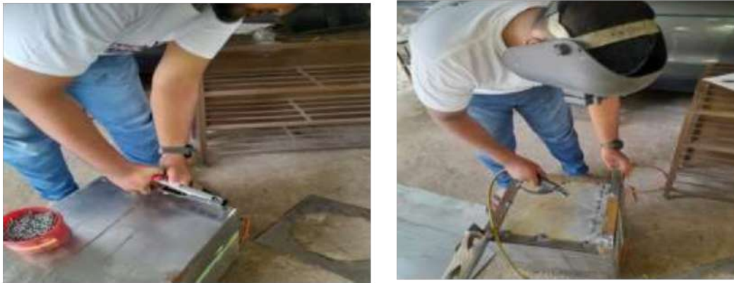
Gambar 4.8 Pemasangan rivet dan Pengelasan bagian bawah kompor
