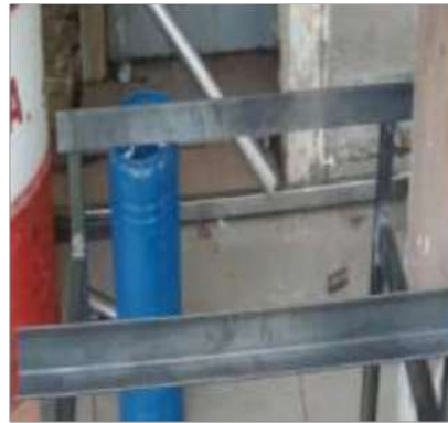
Gambar 4.7 Pengelasan bagian rangka Roller Sumber: Dokumentasi Pribadi
