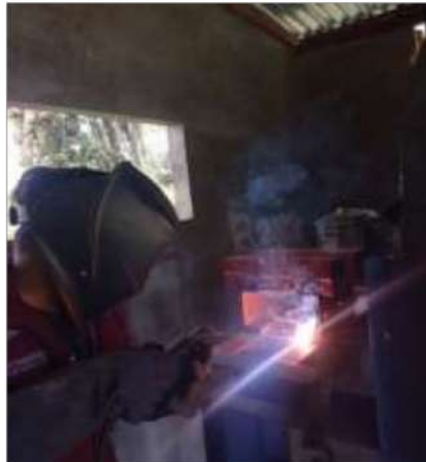
Gambar 4.5 Pengelasan Besi Dudukan Motor Listrik Sumber : Dokumentasi Pribadi
