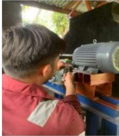
Gambar 4.8 Pemasangan Motor Listrik pada Dudukan Sumber : Dokumentasi pribadi
