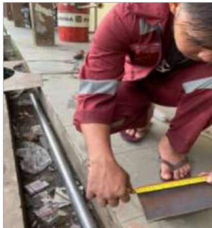
Gambar 4.3 Pengukuran Besi UNP Sumber : Dokumentasi Pribadi
