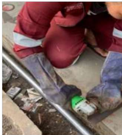
Gambar 4.4 Pemotongan Besi UNP Sumber : Dokumentasi Pribadi
