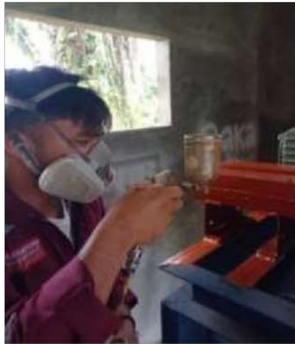
Gambar 4.7 Pengecatan Dudukan Motor Listrik Sumber : Dokumentasi Pribadi
