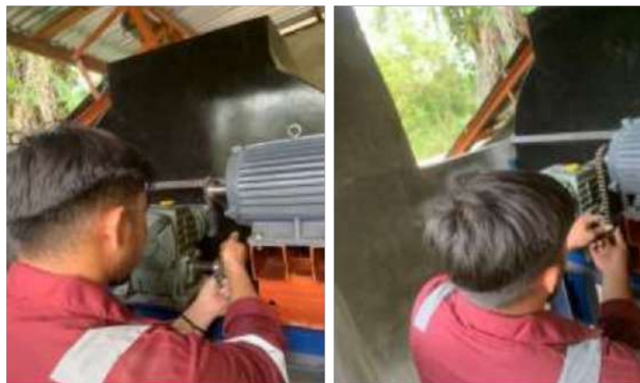
Gambar 4.9 Pemasangan Sprocket dan Rantai Sumber : Dokumentasi Pribadi
