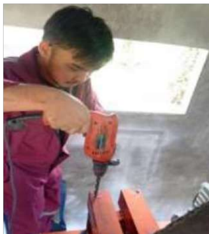
Gambar 4.6 Pengeboran Lubang Baut pada Besi UNP Sumber : Dokumentasi Pribadi
