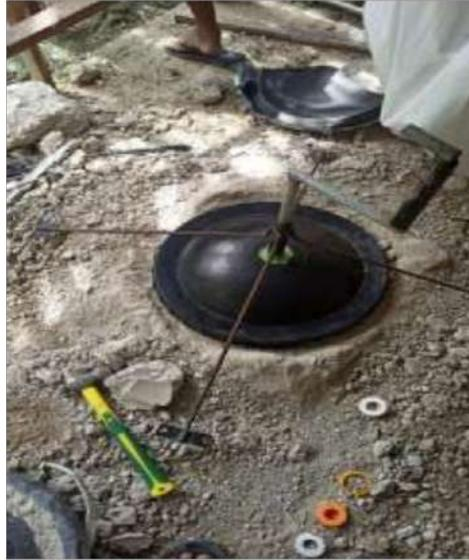
**Gambar 4. 13** Pemansangan pengaduk manual ke digester manual
