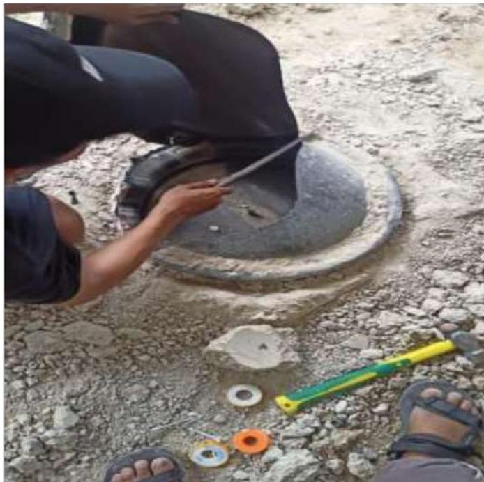
**Gambar 4. 12** Pembongkaran tutup digester sebelum menggunakan pengaduk
