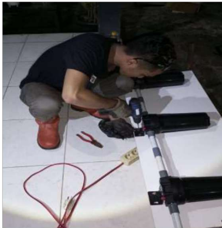
Gambar 4.10 pemasangan filter housing pada kedudukan
