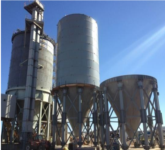
Gambar 5.3. Penyimpanan Bahan Baku di Dalam Silo
