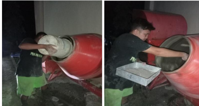
Gambar 4. 8. Proses Pencampuran Semen, Agregat, Air dan ATKKS
