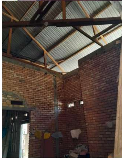
(a). Kondisi Plafon dalam keadaan bersih
