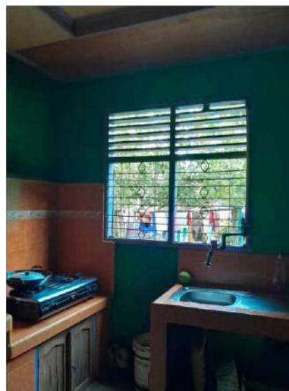
Gambar 4. 16. Lubang Asap Dapur
