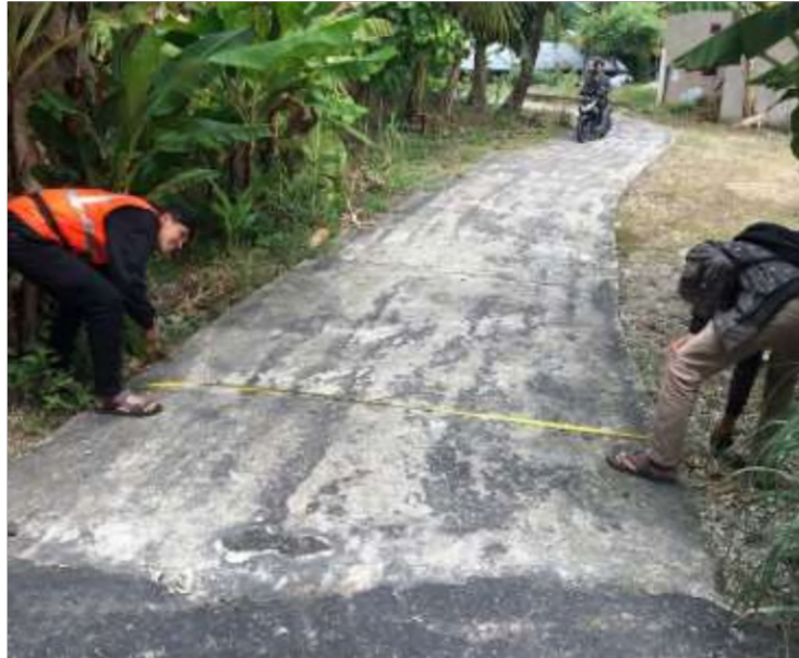
Gambar 4. 11 Pengukuran Dimensi Jalan ( dokumentasi lapangan )
