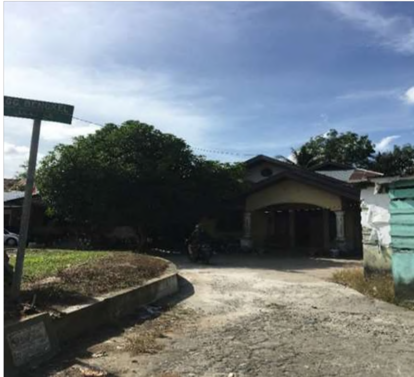
Gambar 4. 9 Kerusakan Gg. Bengkel 1 ( dokumentasi lapangan )
