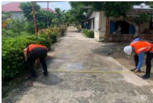
Gambar 4. 1 Proses pengukuran jalan lingkungan Sumber: Dokumentasi pribadi
