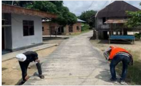
Gambar 4. 3 Pengukuran jalan Lingkungan Sumber:Dokumentasi pribadi
