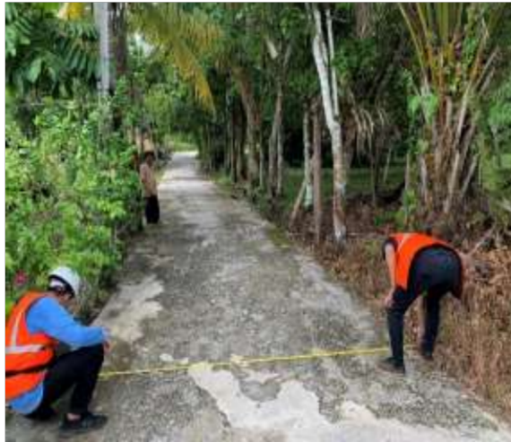
Gambar 3. 2 Proses Pengukuran Jalan Lingkungan Sumber:Dokumentasi pribadi
