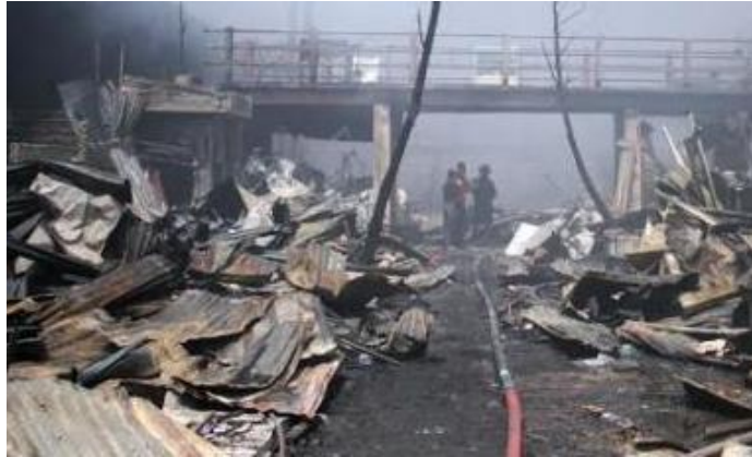
Gambar 3. Reruntuhan Bangunan Pasca kebakaran (Jateng.tribunnews.com)
